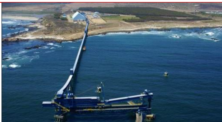
图表 8 Los Pelambres 海水淡化工厂已经接近完工
